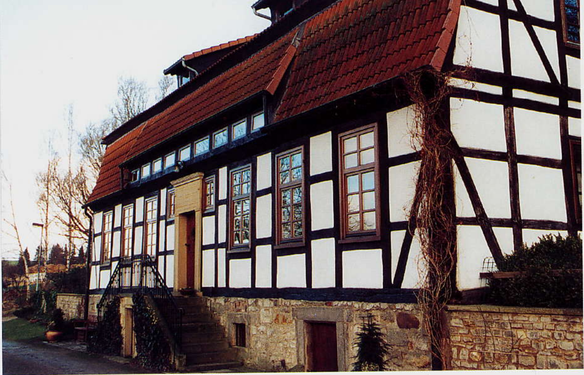
Wittenburg – Das 1803 erbaute Verwalterhaus der ehemaligen Domäne Wittenburg. Restauriert durch den jetzigen Besitzer Wolfgang Küster.
