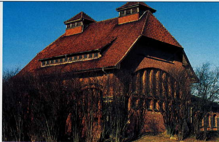
Wülfigen – Das 1910 errichtete Wasserwerk bei Wülfigen. Inzwischen stillgelegt steht es als Industriegebäude unter Denkmalschutz.
