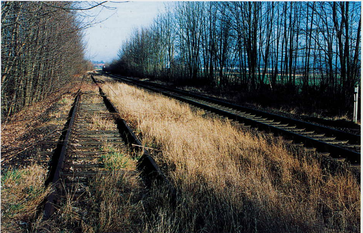
Mehle – Totes Gleis am alten Mehler Bahnhof. Im Jahre 1986 ist der Mehler Bahnhof geschlossen worden.
