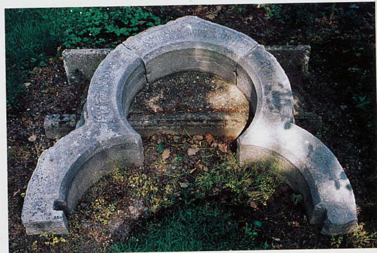
Mehle/Elze – Der Portalbogen der ehemaligen Mehler Synagoge.
