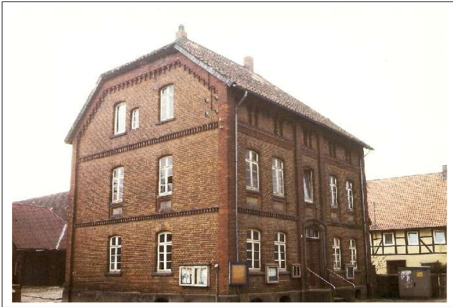
Das ehemalige Gemeindebüro Mehle
