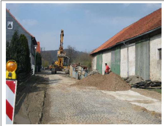
Bauarbeiten in der Bruchstraße im Sommer 2008
