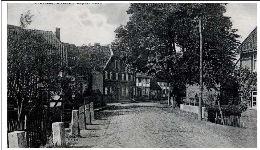
Die „alte“ noch unverbreiterte Limbachbrücke Ortsausgang Elze
