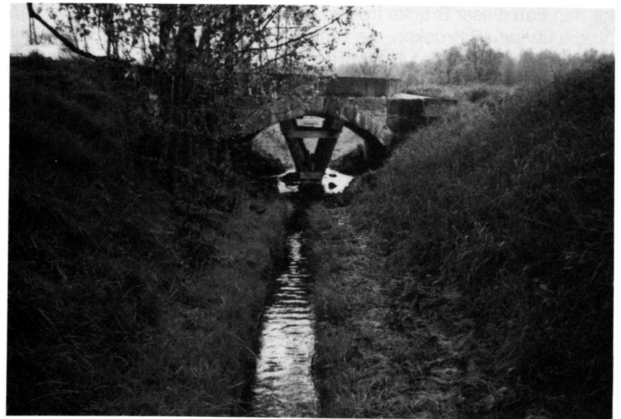
Bild 30: Gewölbebrücke über Asbestgraben – für Baufahrzeuge abgestützt
