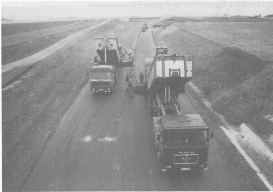
Bild 33: Straßenfertiger nehmen Asphalt auf und legen Schlußdecke Foto: 1988
