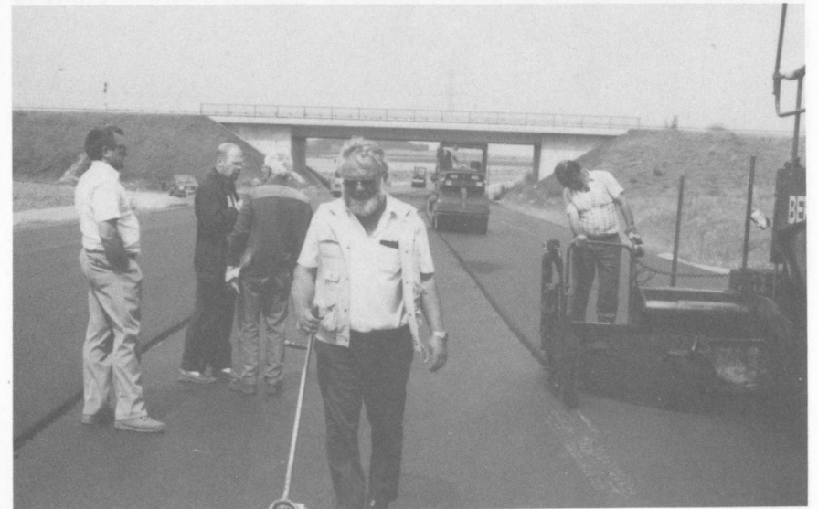
Bild 36: Schlußdecke legen und festwalzen Foto: 1988
