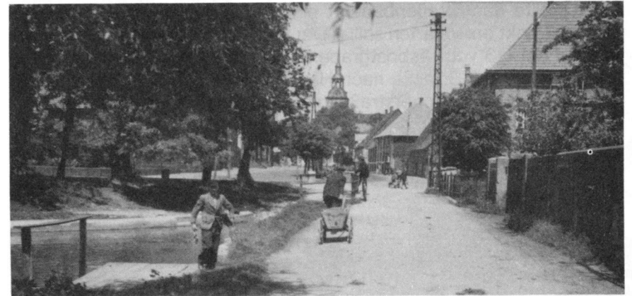
Bild 2: Saaledamm und Saale-Mühlengraben
