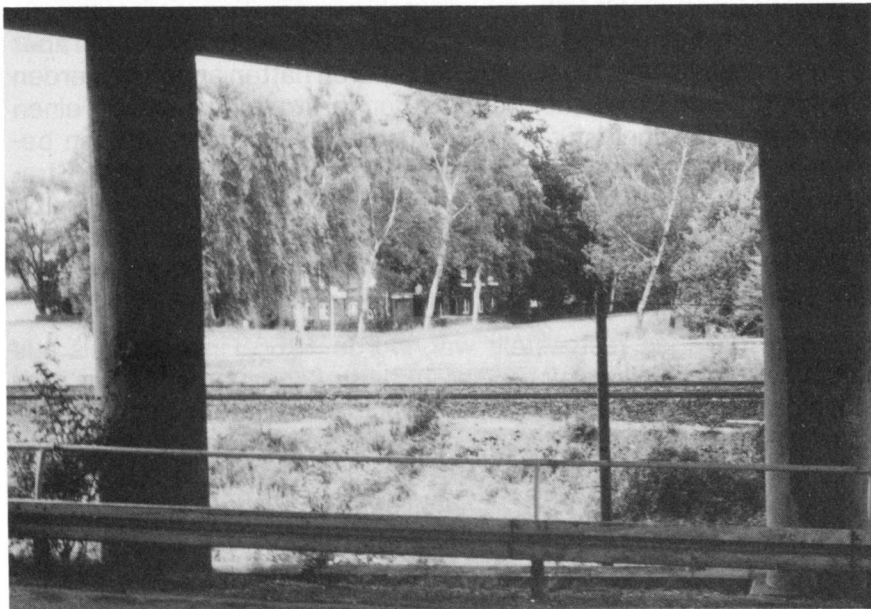
Bild 24: Bahnübergang (bis 1969) der Hamelner DB-Strecke
