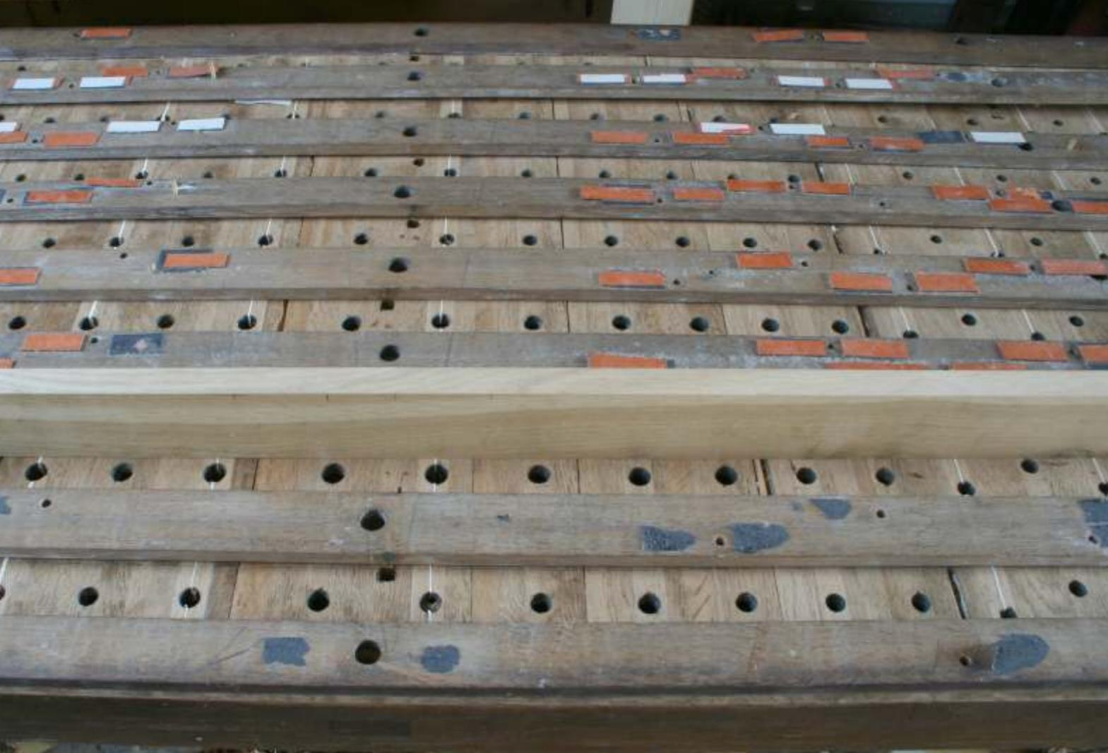
Um künftige Trocknungsschäden an den wertvollen Bauteilen zu verhindern, wurden die Windladen im Zuge der Restauration mit entsprechenden Dehnungsfugen versehen. Diese erlauben in einem gewissen Rahmen ein Trocknen und Quellen des Holzes, ohne dass hierdurch die Windkammern in Mitleidenschaft gezogen werden.
